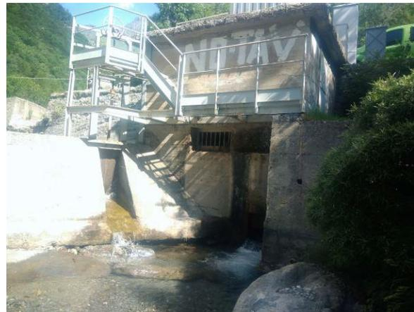
**Figura 4:** opera di presa sul torrente Clarea, vista da monte da sponda sinistra e da valle.
